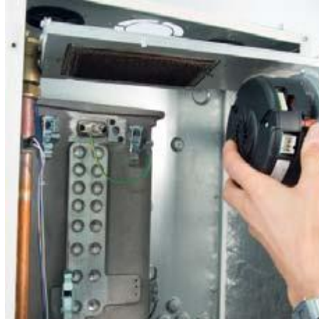
Odstranitev kompletnega izgorevalnega sistema
