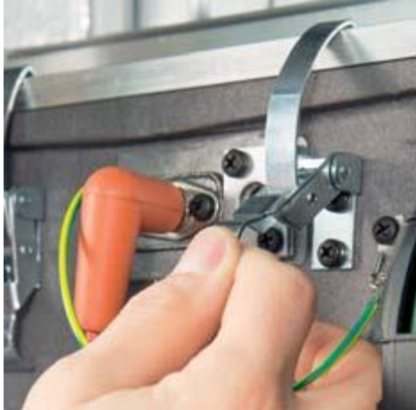
“Quick Release” odstranitev izgorevalnega sistema
